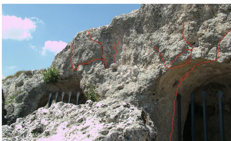
Fig. 5 - Fratturazioni esterne con definizione di poliedri rocciosi suscettibili a crollo.
