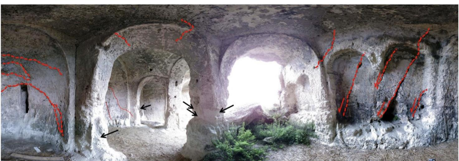
Fig. 13 - Evidenza dello stato di fratturazione interna e delle erosioni dei pilastri della Chiesa di San Pietro in P.
