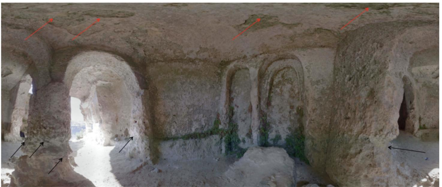
Fig. 10 - Desquamazioni delle volte e erosione alla base dei pilastri, provocate anche dal successivo riutilizzo di tali ambienti come ricovero per gli animali che muovendosi potevano produrre attriti laterali lungo le pareti e le parti basse dei pilastri.
