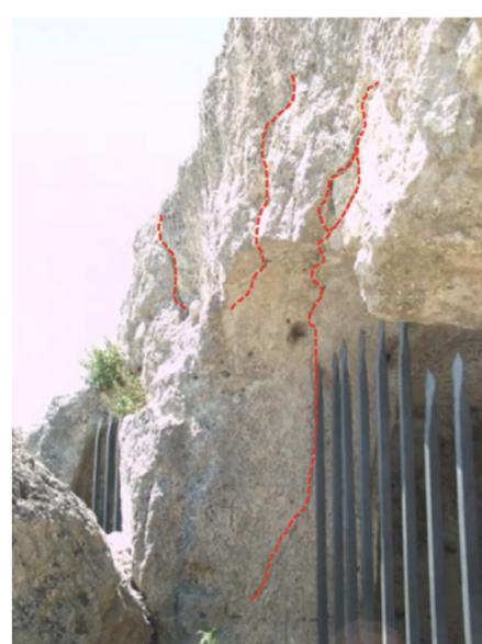
Fig. 6 - Altro esempio di fratturazioni esterne con definizione di poliedri rocciosi suscettibili a crollo.
